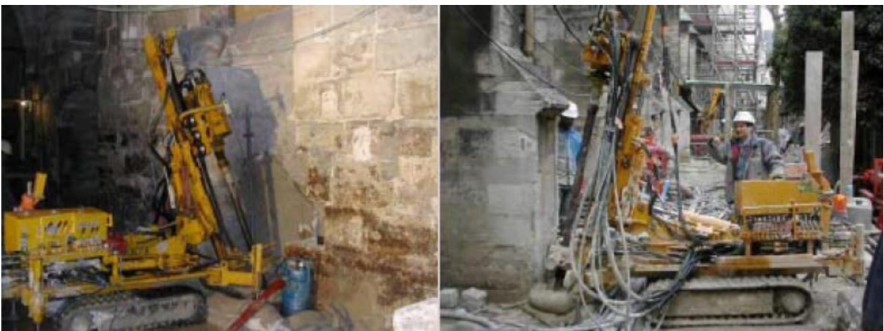
Fig. 14 – Perforazione inclinata all'interno e all'esterno della costruzione
