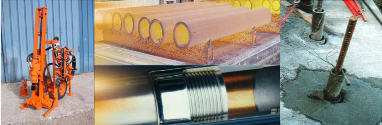
Fig. 12 – A sinistra: piccola perforatrice. In centro: fabbricazione dei tubi e raccordo filettato. A destra: particolare di estremità di un palo
